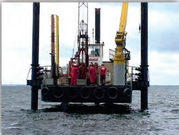
EGS CME 550 on Spud Barge
